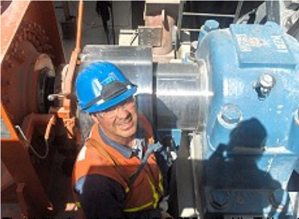
El montaje de un motor eléctrico de 2500 CV para la planta de tratamiento de aguas residuales de la ciudad de Madrid. Obra de Montaje Mecánico, estructural y piping.
