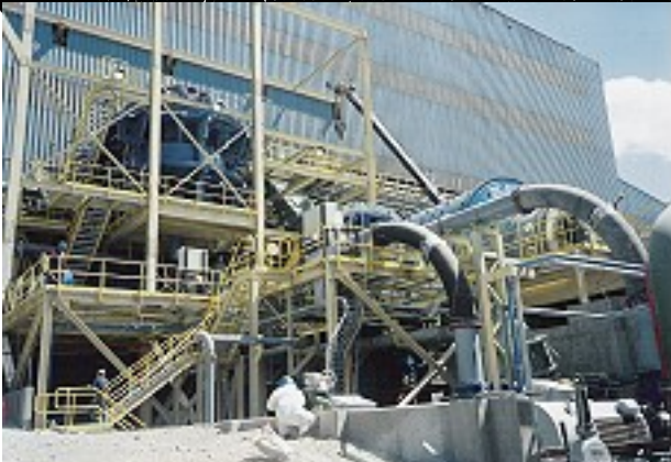
El montaje de un motor eléctrico de 2500 CV para la planta de tratamiento de aguas residuales de la ciudad de Madrid. Obra de Montaje Mecánico, estructural y piping.
